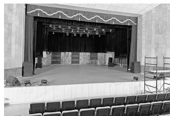
Ремонт в ДК Култаево
